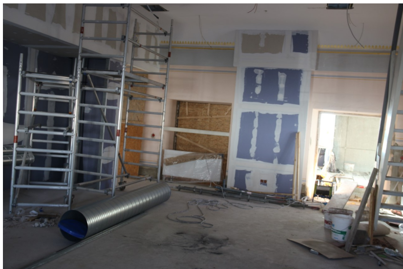
Bild: Hier entsteht der neue Jugendraum
